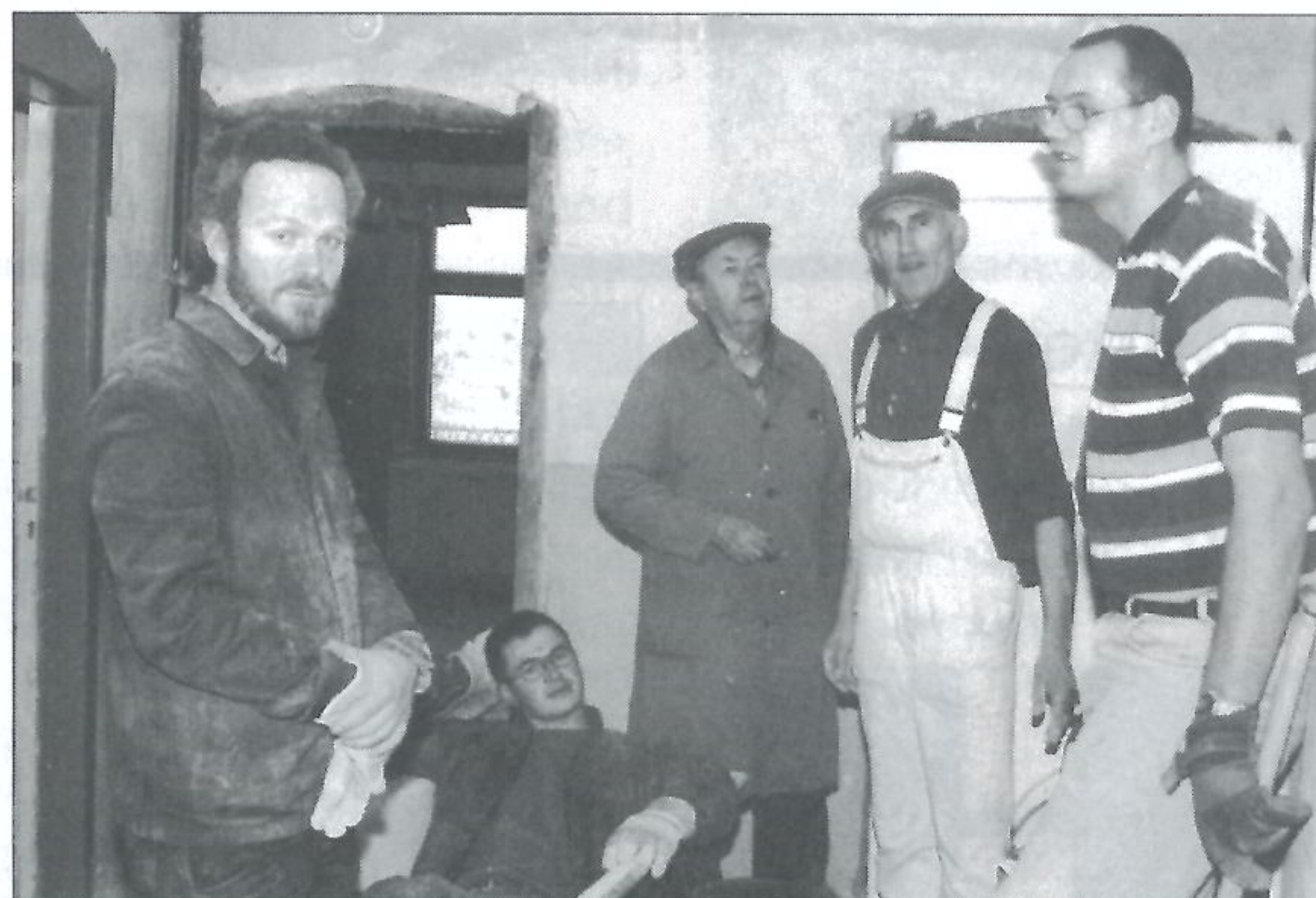
Noch einmal kurz ausruhen, bevor diese Badewanne hinuntergeschleppt wird; auch die Sanitäranlagen müssen völlig erneuert werden
