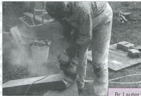
Br. Lauter beim Zusägen von Steinplatten für die Gehweggestaltung in Friedensau
