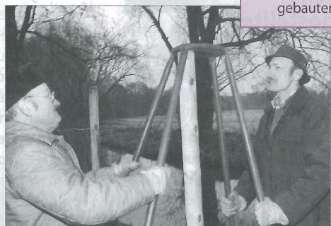
Br. Schoßnig und Br. Siebeneicher beim Einrammen von Holzpfählen mit einer selbstgebauten "Ramme"
