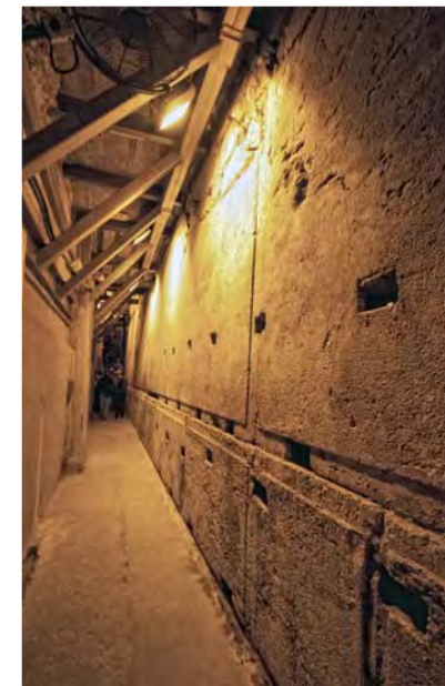
Grundmauern des Tempelberges Foto: Friedbert Ninow
